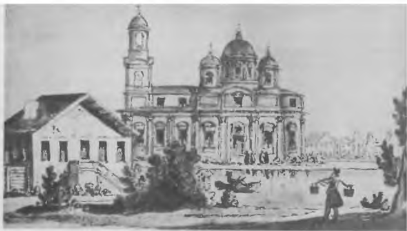
Князь-Владимирский собор в Петербурге
